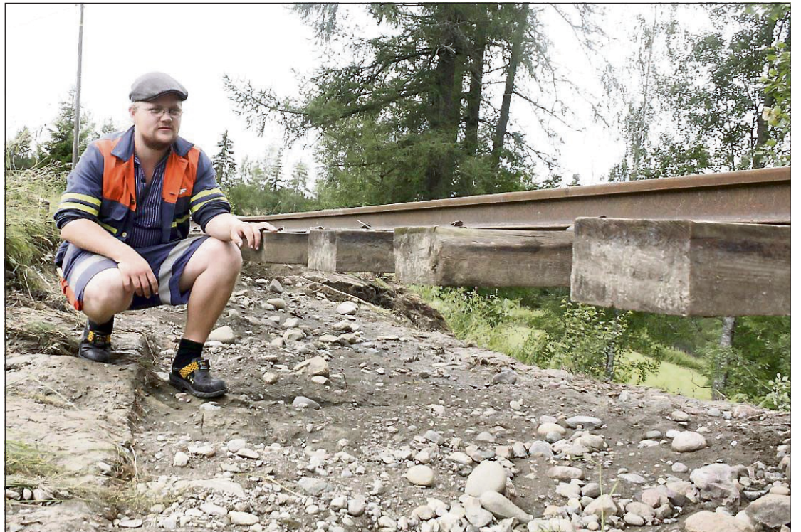
NESTEN ÉN METER: Mellom 70 og 80 centimeter har sklidd ut under skinnegangen på deler av Urskog-Hølandsbanen. - Skader i millionklassen, sier driftstekniker Are Eeg. FOTO: ESPEN BØRRESTUEN
